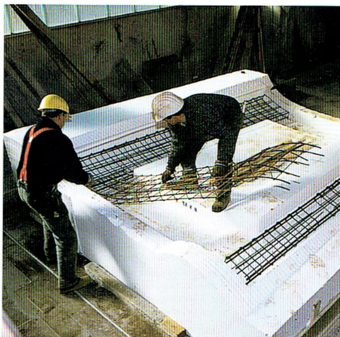
Bild 6: Bewehren der Styroporform im Fertigteilwerk (Haus B)
