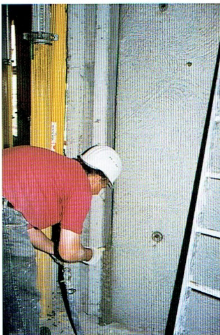
Bild 3: Schließen der Fertigteilfugen mit Spezialmörtel in Haus A
